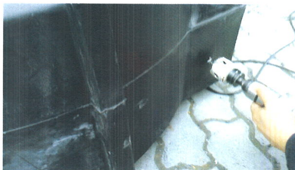
2. bemenetek kifűrése
