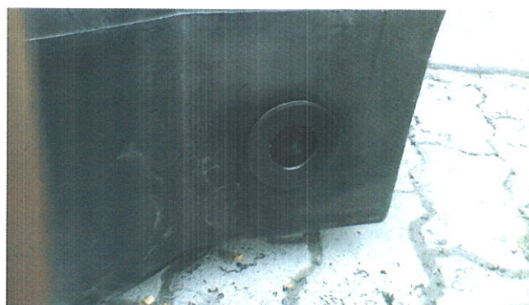
4. gumitömítés behelyezése
